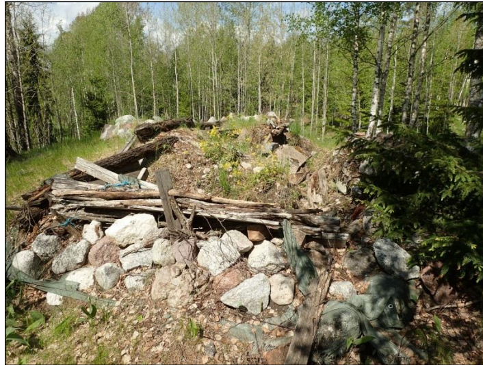
Laella eli katolla kiveä ja puuta jonka alla pressu – bunkkerin aukkoja on yritetty peittää.
