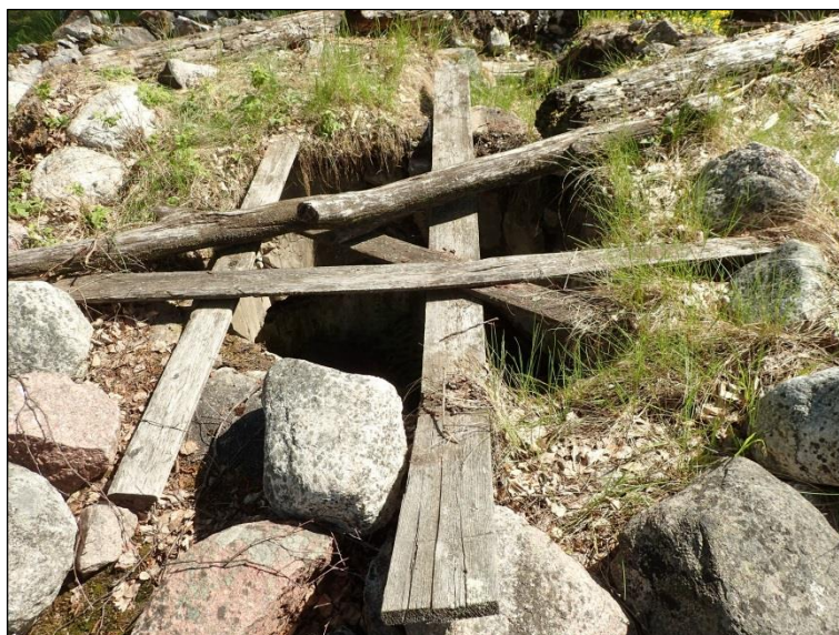
Katolla oleva aukko, siinä betoniseinät.
